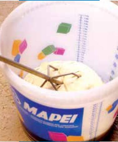
Mezcla de Mapeset con agitador mecánico
